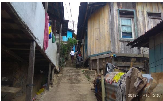
Gambar 3. Kondisi fisik permukiman di Kelurahan Sidodamai
