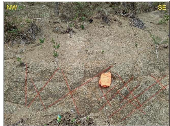
Gambar 6. Shear fractures pada batuan granit di St 3.
